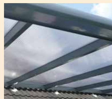
Dakpanmontage 2, montage op schuin dak
