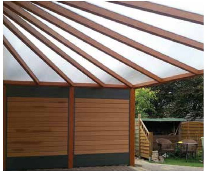
Waaierdakconstructie met aluminium/composiet zijwand
